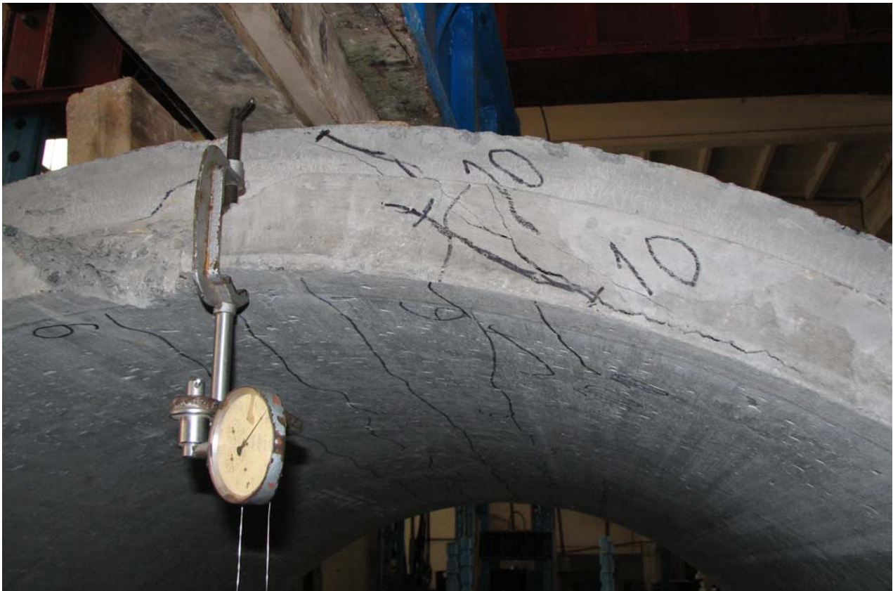
Рисунок 3. Характер образования трещин в шельге трубы нагружением
