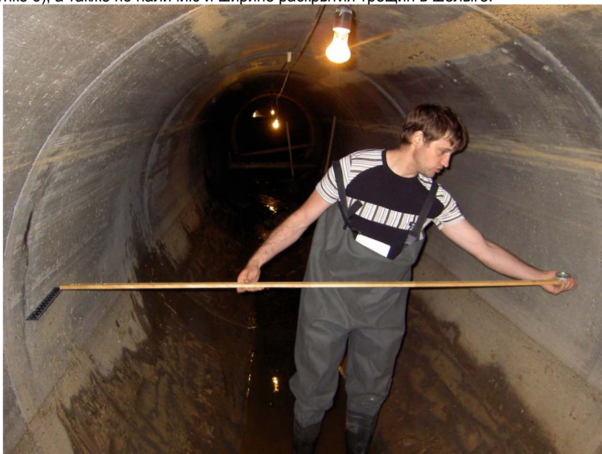
Рисунок 6. Внешний вид коллектора при выполнении измерений деформации кольцевого сечения труб.
