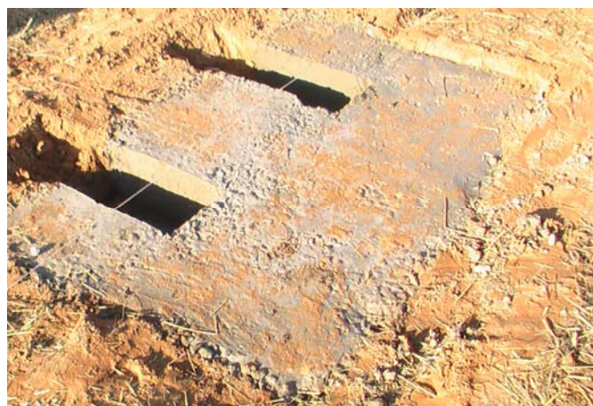
Фото 5 - Готовый ФСМ под опоры трехшарнирных рам
