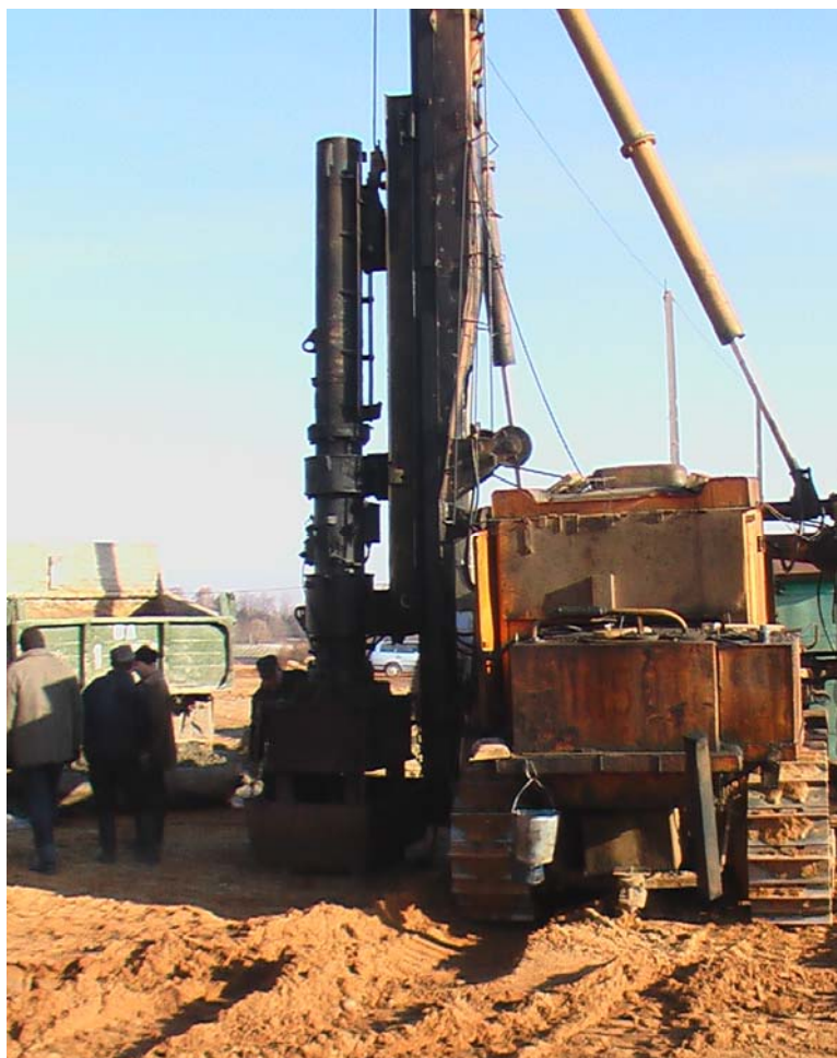
Фото 2 - Установка штампа-скважинообразователя ФСМ на точку забивки
