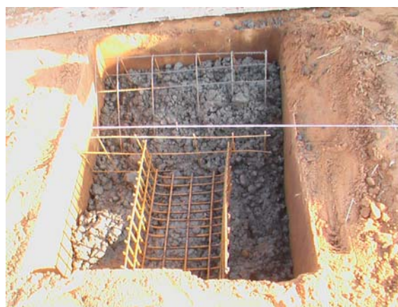
Фото 4 - Выштампованный котлован под ФСМ и его бетонирование
