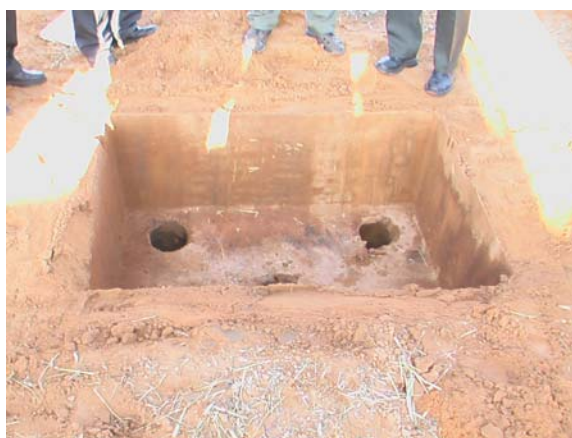
Фото 4 - Выштампованный котлован под ФСМ и его бетонирование
