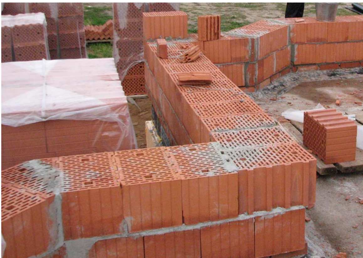
Выполнение криволинейных участков стен здания из крупноформатных блоков из поризованной керамики
