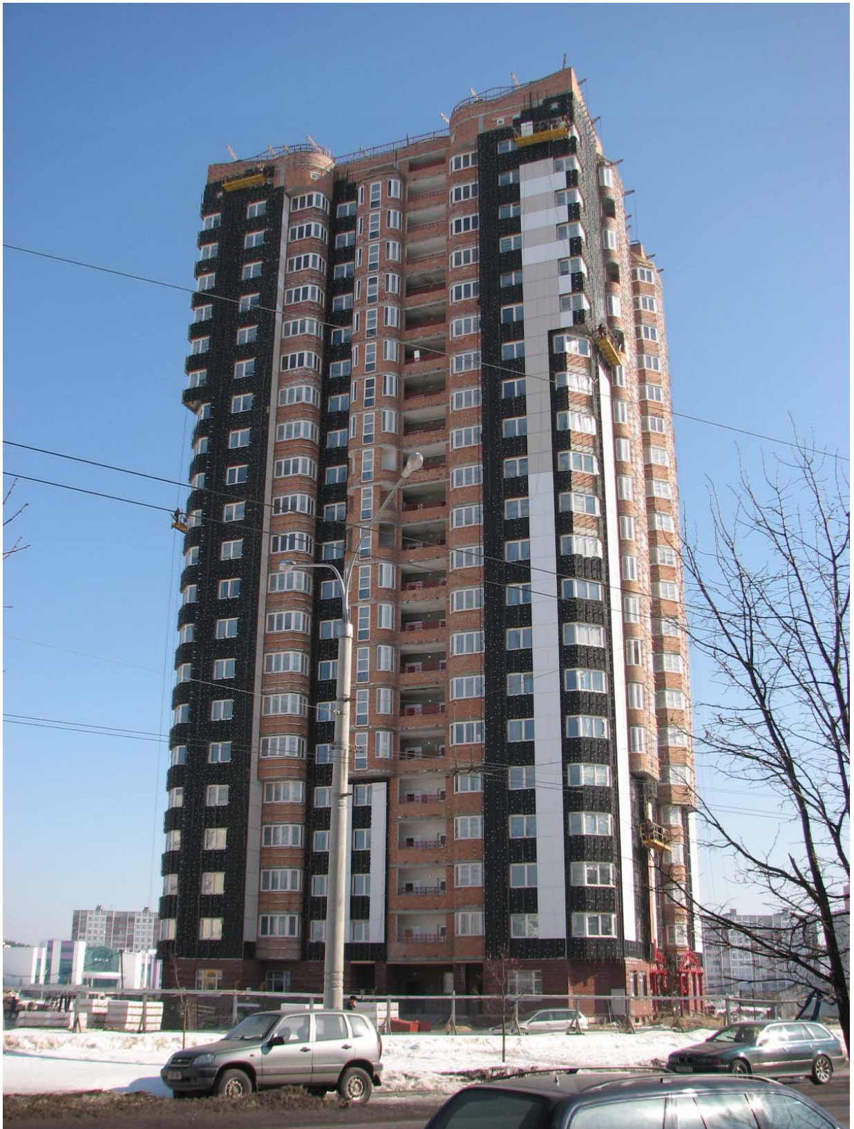
21-этажный жилой дом с несущим каркасом из монолитного железобетона и поэтажно опертыми наружными стенами из поризованных керамических блоков (ул.Шафарнянская, г.Минск)
