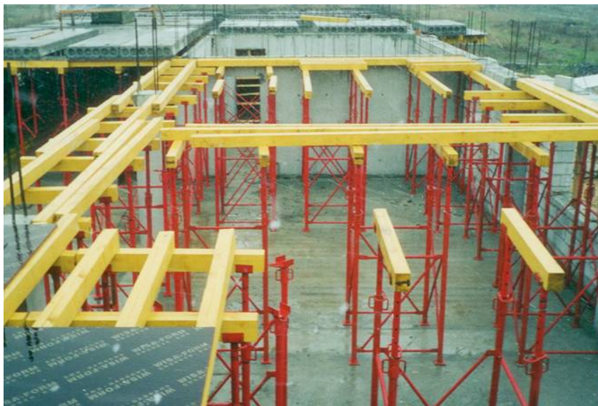
Рисунок 9 – Возведение сборно-монолитного перекрытия жилого дома
