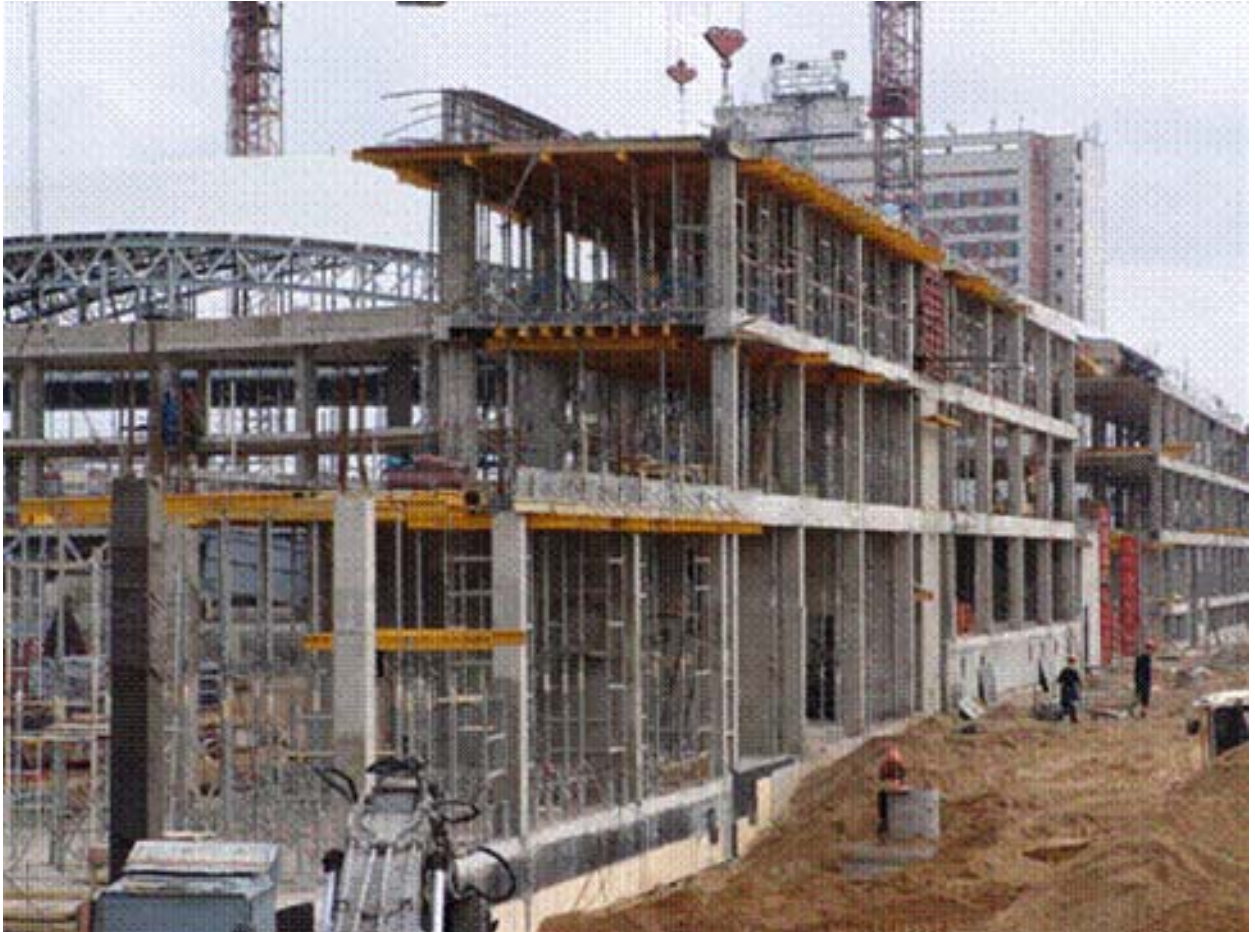
Рисунок 14 – Поточная технология возведения каркаса велодрома
