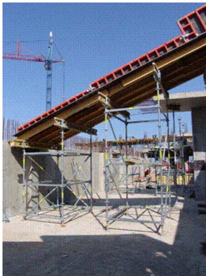
Рисунок 18 – Возведение монолитных балок наклонных трибун
