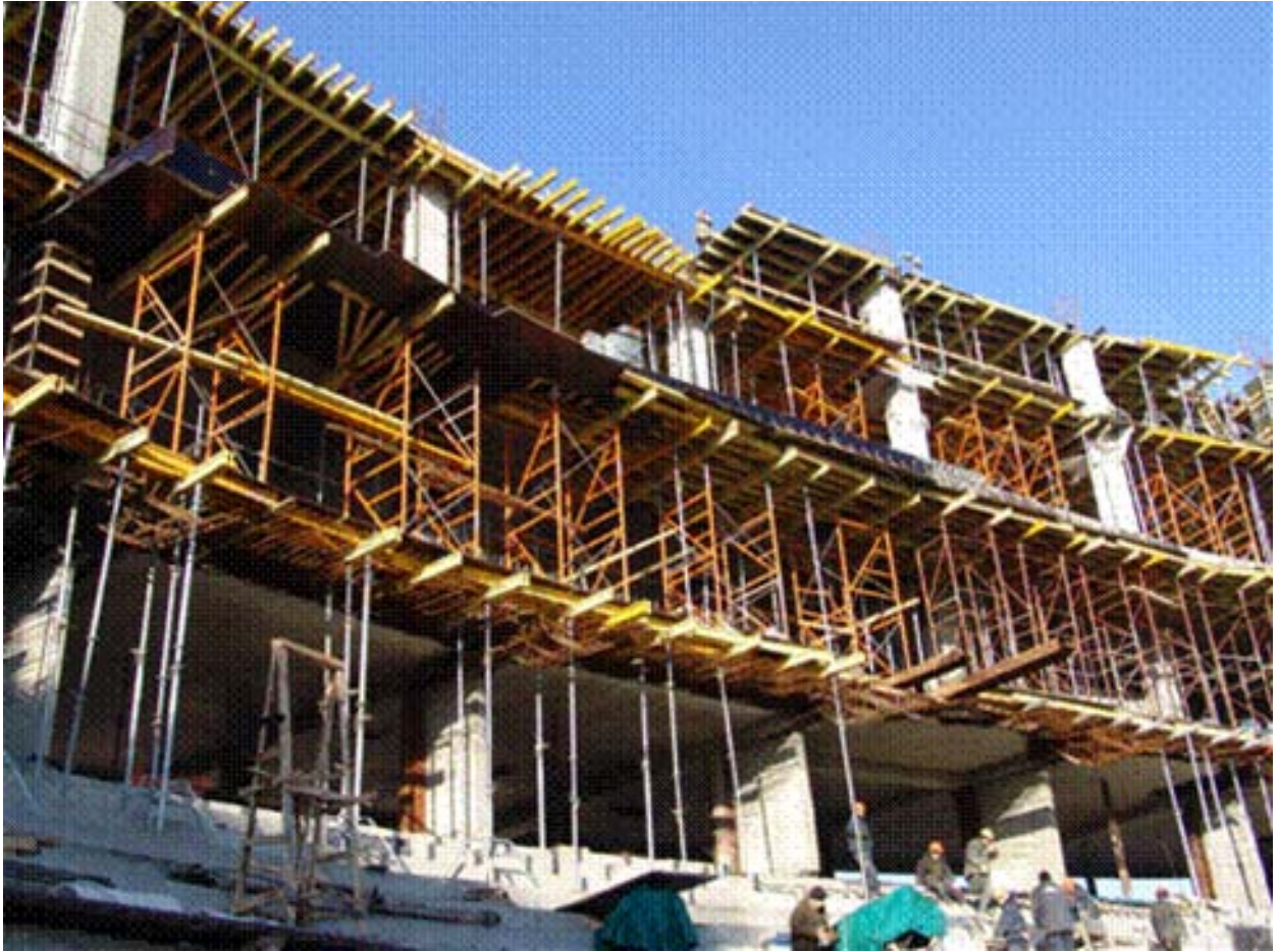
Рисунок 13 – Возведение монолитного перекрытия с применением опорных башен ПОРТАЛ
