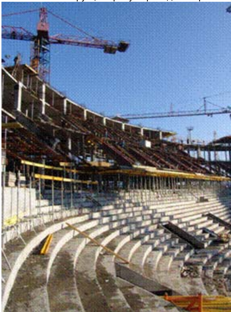
Рисунок 20 – Возведение монолитных конструкций наклонных трибун: а) нижнего яруса; б) верхнего яруса
