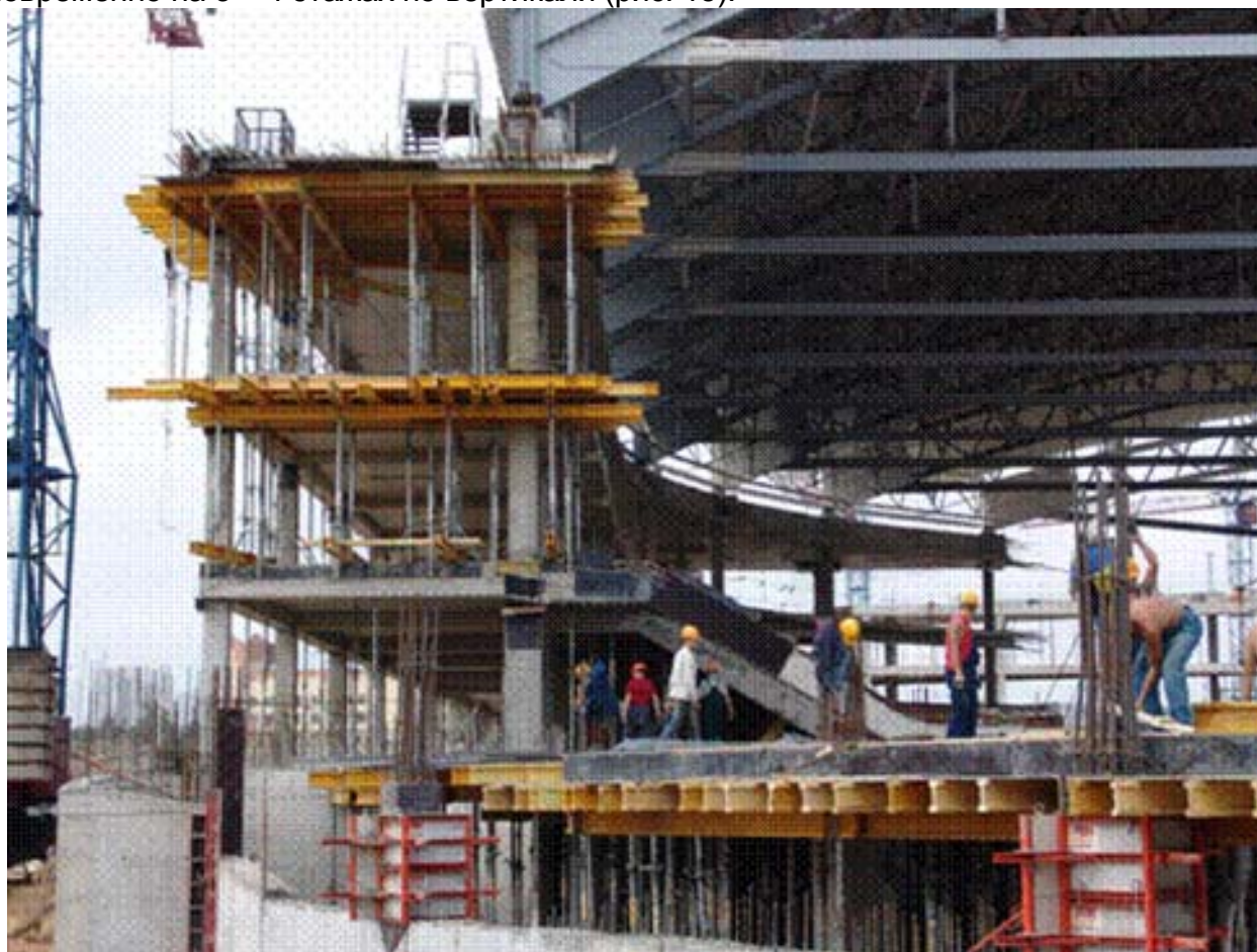
Рисунок 15 – Каскадная технология возведения каркаса велодрома
