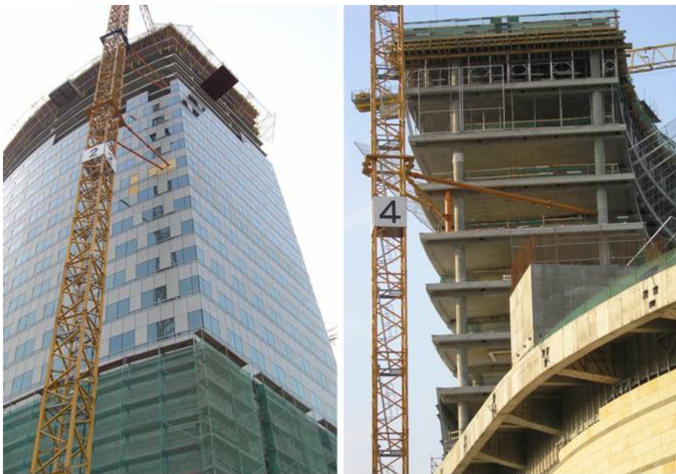
Рисунок 7 – Крепление приставного башенного крана к каркасу здания (г. Варшава, Польша, 2007 г.)
