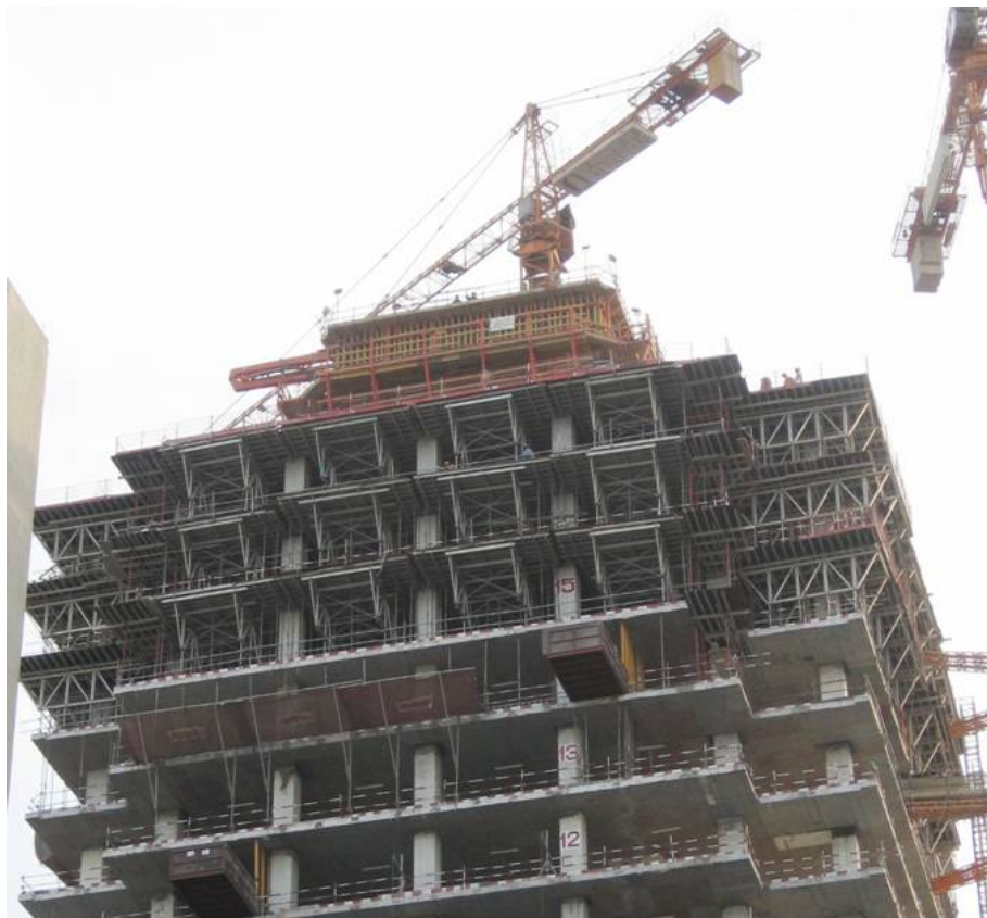
Рисунок 11 – Технологические площадки фасадов высоток (г. Дубай, 2008 г.)
