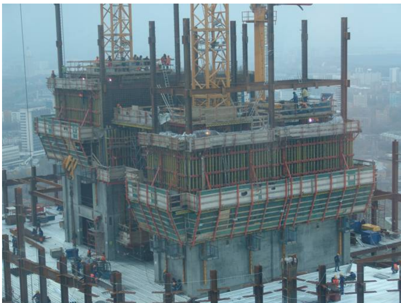
Рисунок 6 – Самоподъемная опалубка при строительстве небоскреба в г. Москва (Россия, 2008 г.)
