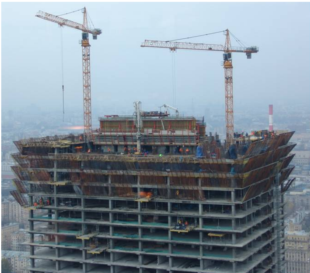
Рисунок 8 – Возведение монолитных конструкций с использованием самоподъемного крана (г. Москва, Россия, 2008 г.)
