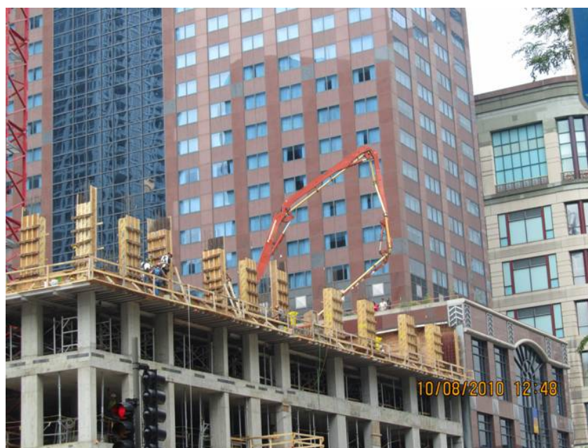
Рисунок 3 – Укладка бетонной смеси с использованием распределительной стрелы (г. Чикаго, США, 2010 г.)
