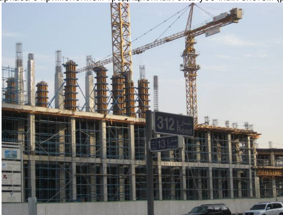
Рисунок 4 – Возведение здания высотой 20 этажей с применением традиционных опалубочных систем (г. Дубай, 2008 г.)
