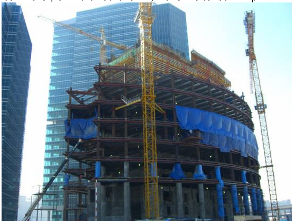
Рисунок 12 – Установка ветрозащитных ограждений на фасаде высотного здания (г. Москва, Россия, 2007 г.)
