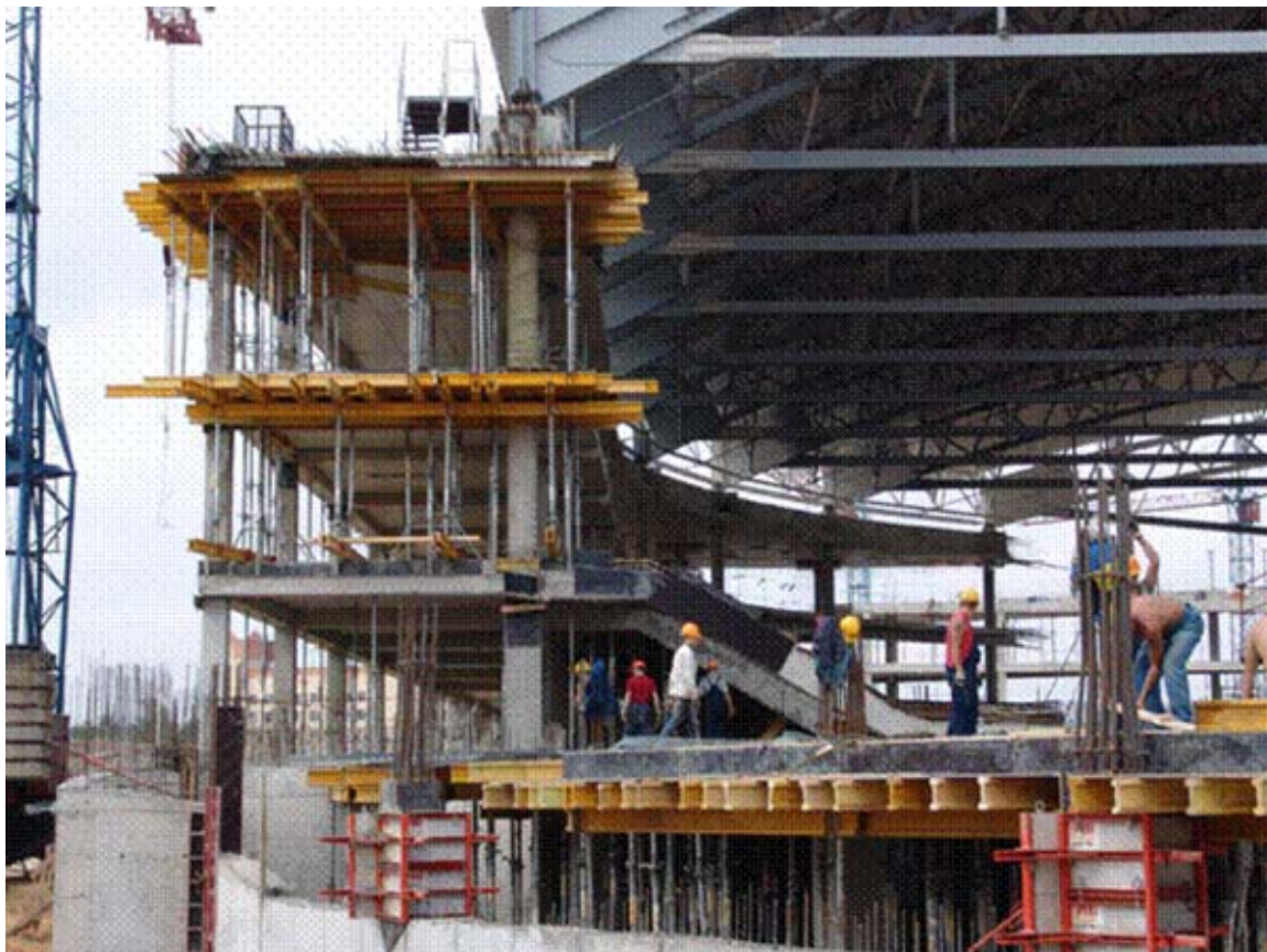
Рисунок 5 – Каскадная технология возведения каркаса велодрома
