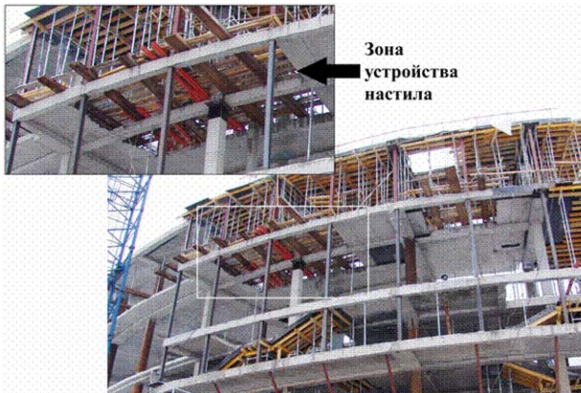
Рисунок 10 – Возведение монолитных конструкций в зоне проемов в перекрытии
