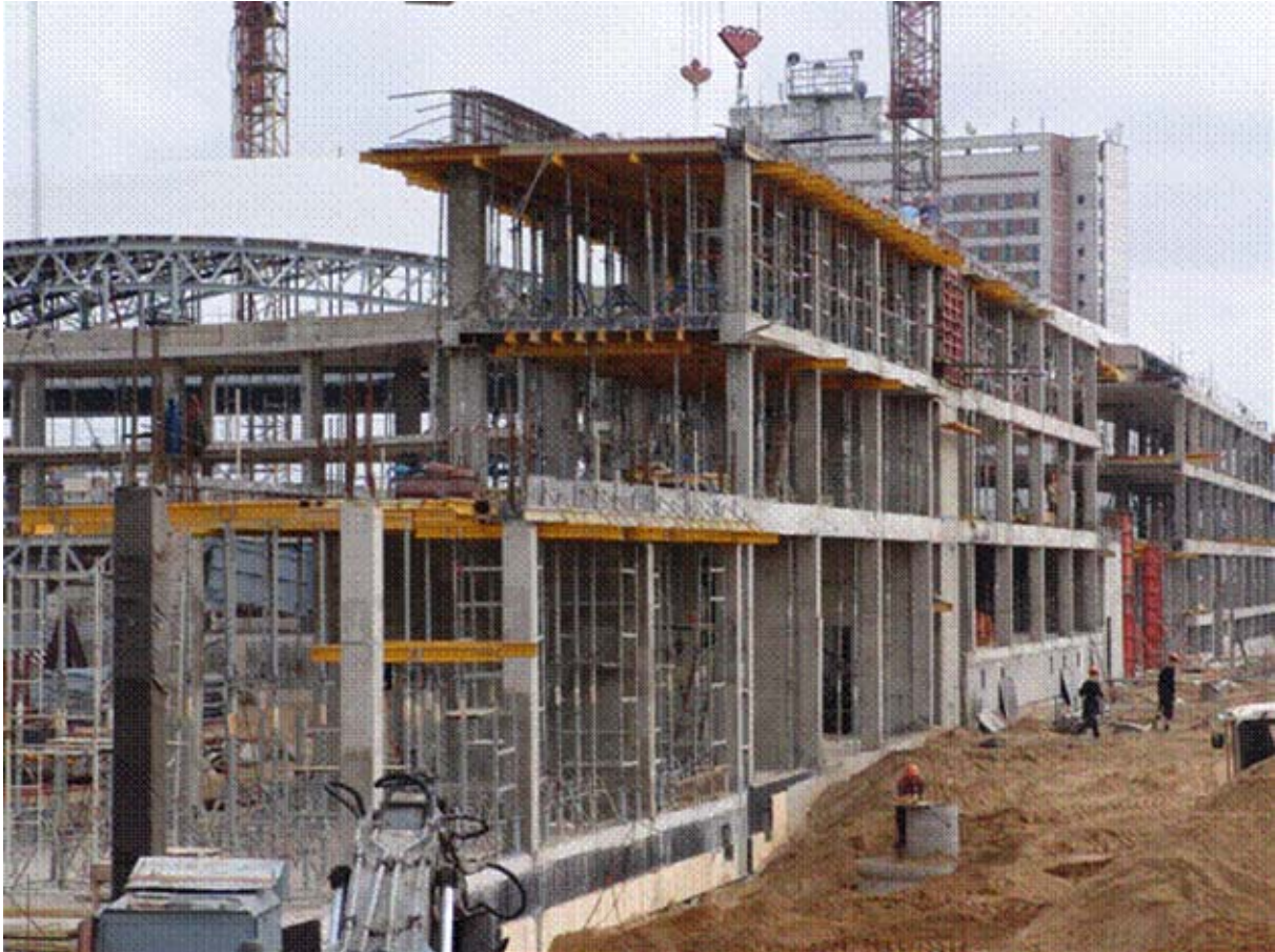
Рисунок 4 – Поточная технология возведения каркаса велодрома
