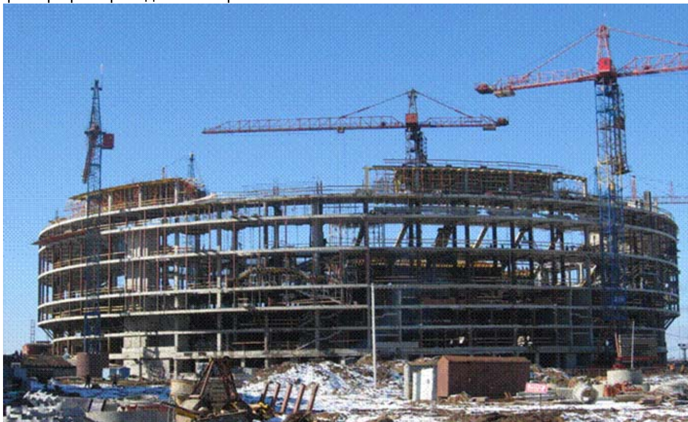
Рисунок 15 – Возведение монолитного каркаса Арены
