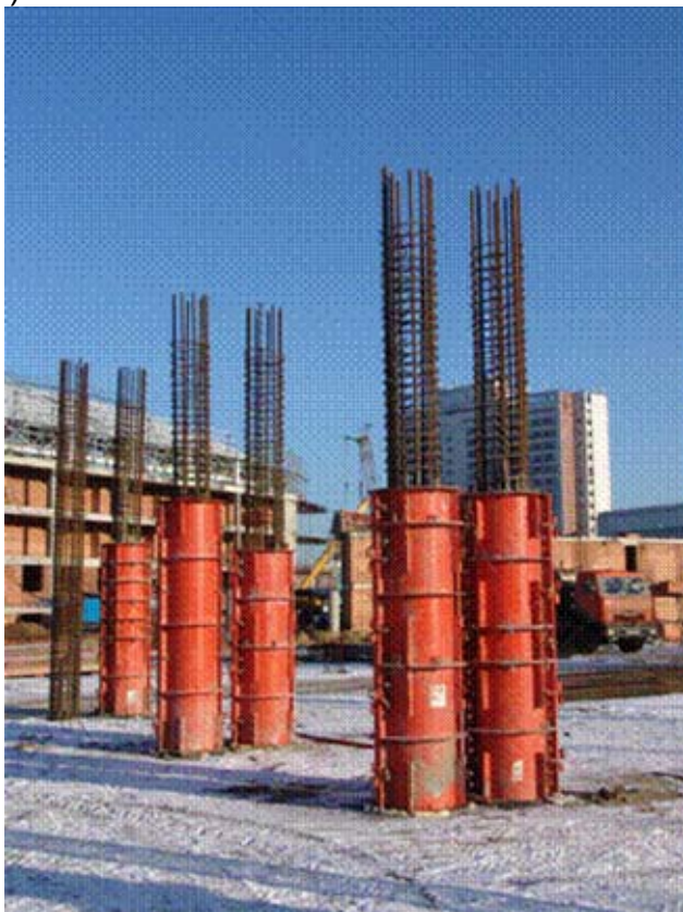
Рисунок 7 – Возведение монолитных колонн:
