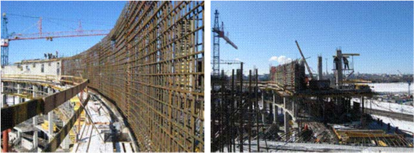
Рисунок 13 – Возведение стен опорного кольца с применением консольных площадок
