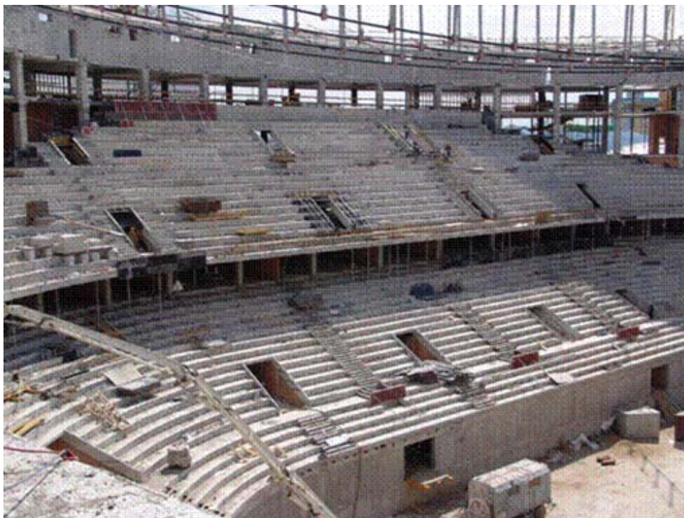
Рисунок 20 – Возведение монолитных конструкций наклонных трибун: а) нижнего яруса; б) верхнего яруса
