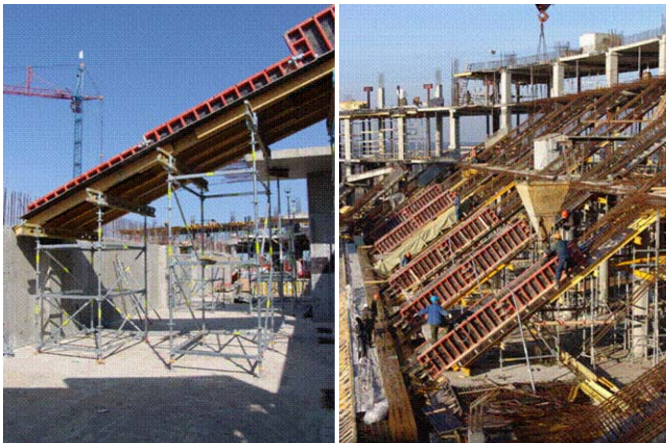
Рисунок 17 – Возведение монолитных балок наклонных трибун
