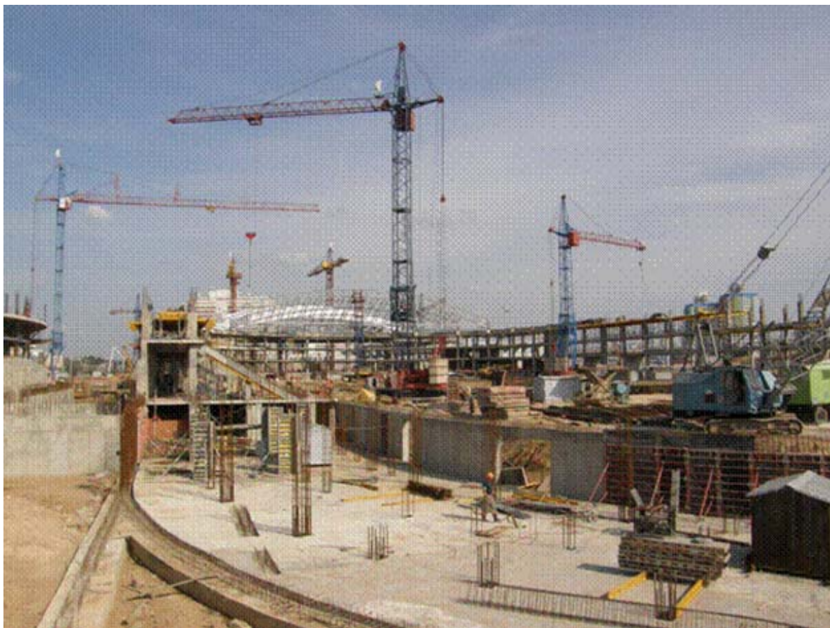
Рисунок 3 – Возведение монолитных конструкций цокольного этажа велодрома
