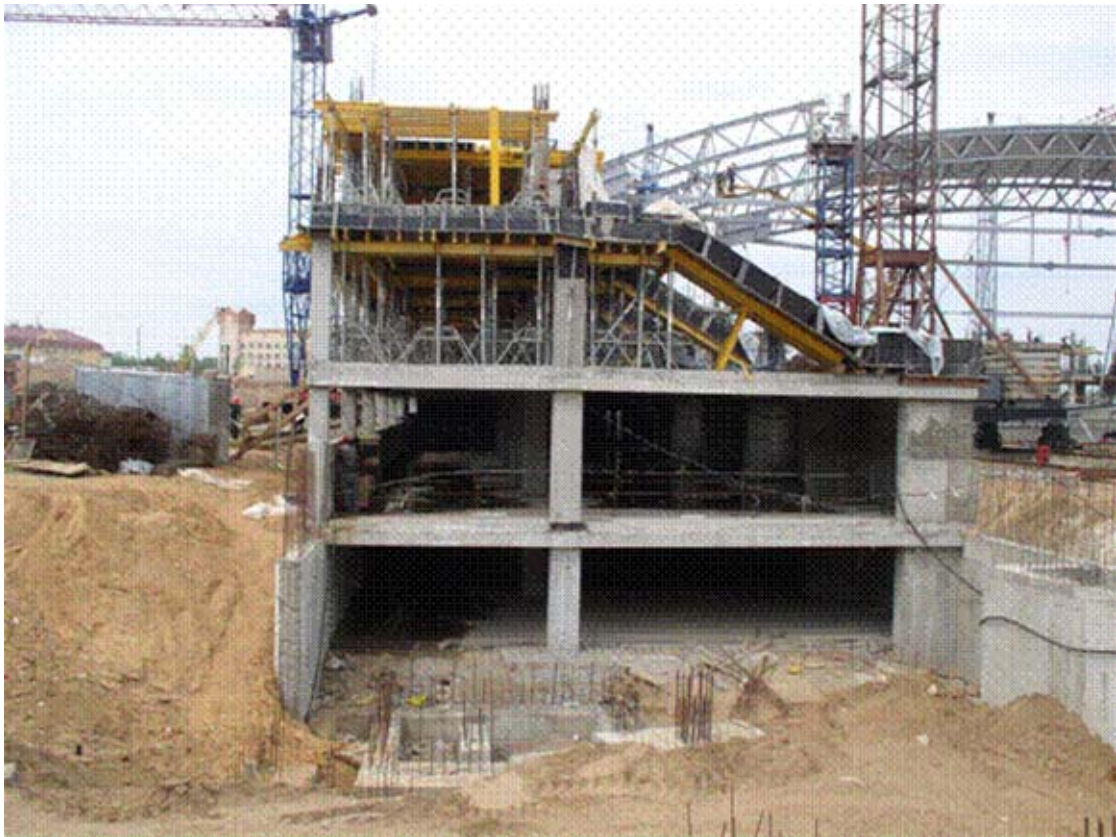
Рисунок 6 – Возведение наклонных ригелей каркаса велодрома в индивидуальной опалубке
