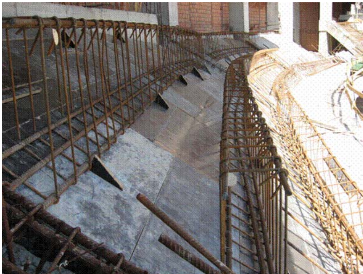
Рисунок 18 – Фиксация арматурных каркасов наклонных трибун
