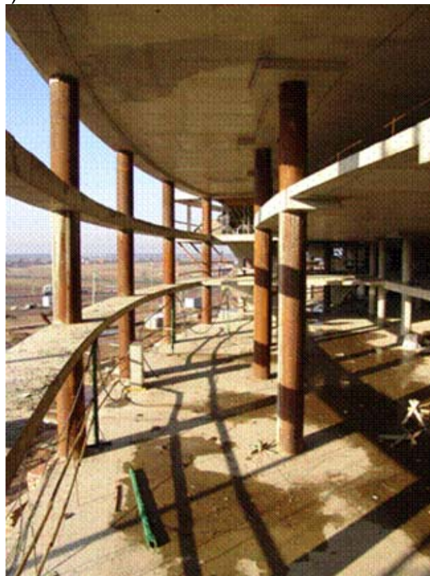
Рисунок 7 – Возведение монолитных колонн:
