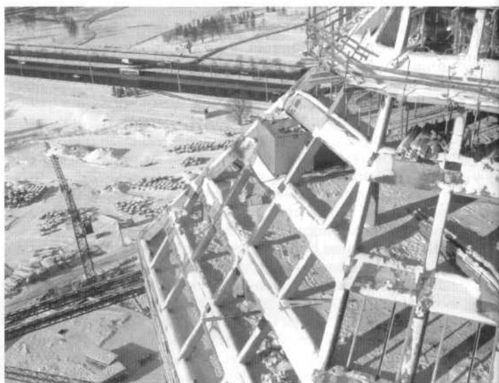
Рисунок 13. Ажурные монолитные конструкции верхней части высотного книгохранилища
