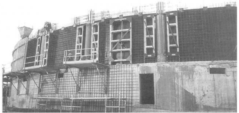
Рисунок 5. Опалубливание круглой монолитной стены с проеомообразователями
