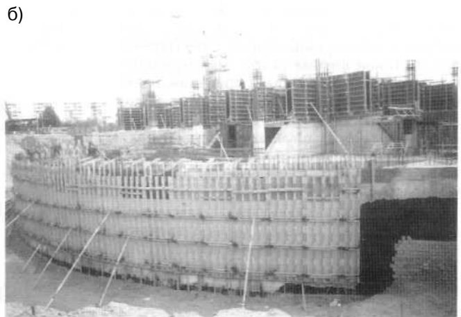
Рисунок 1. Возведение монолитных стен подвала:
