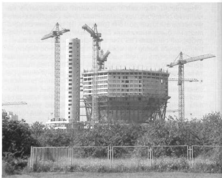
Рисунок 12. Строительство типовых этажей
