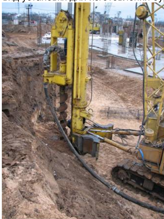
Рисунок 3 - Общий вид установки для изготовления буропрессионных свай
