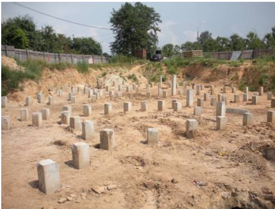
Рисунок 2 - Общий вид свайного поля при строительстве гостиницы на 40 мест, расположенной в районе пересечения пр. Мира и ул. Суворовской в г. Могилеве
