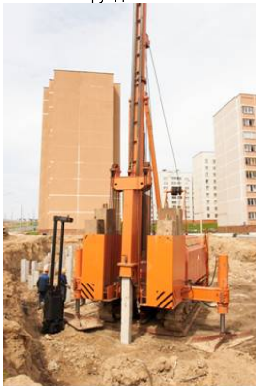
Рисунок 1 - Сваявдавливающая установка СВУ-В-6.
