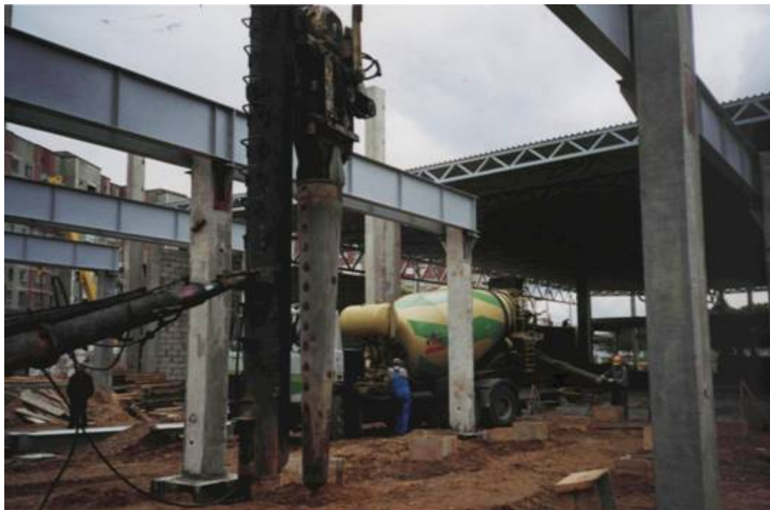
Рисунок 6 - Внедрение вибронабивных свай пирамидальной формы при строительстве гипермаркета «Гиппо».
