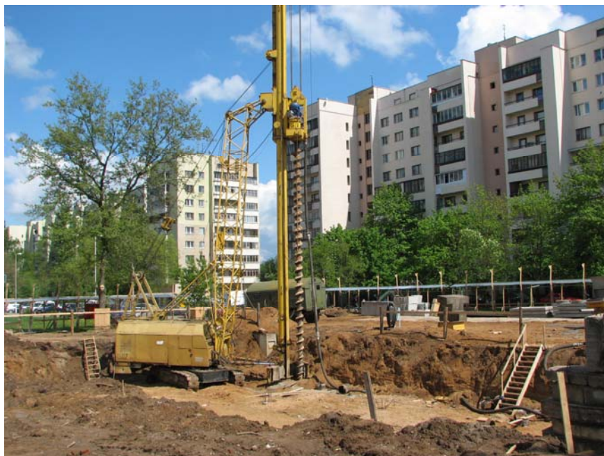
Рисунок 3 - Общий вид установки для изготовления буропрессионных свай
