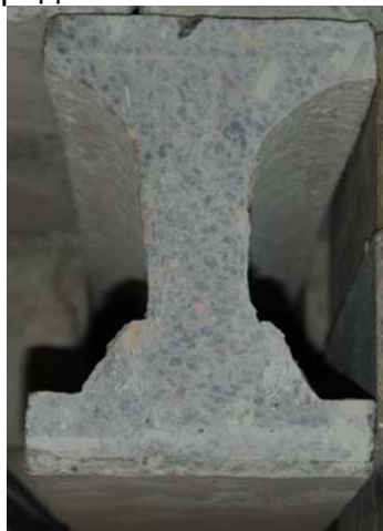
Рисунок 11 – Фрагмент ребра, вырезанного из плиты для определения фактической прочности бетона на растяжение
